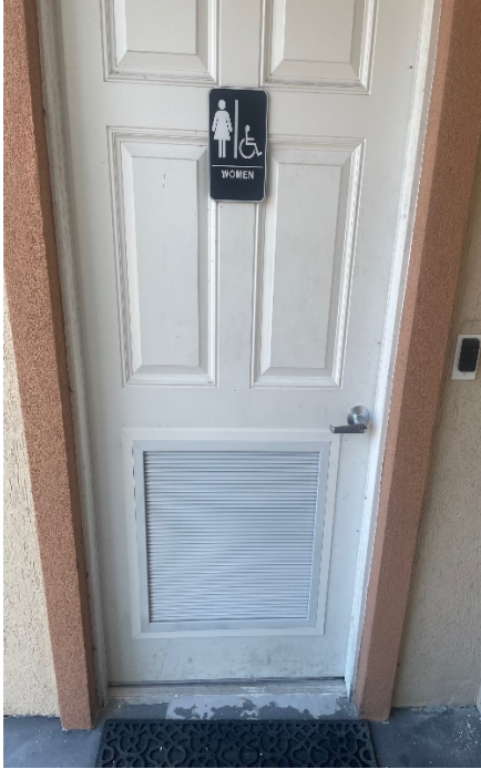
Door louver insallation.
